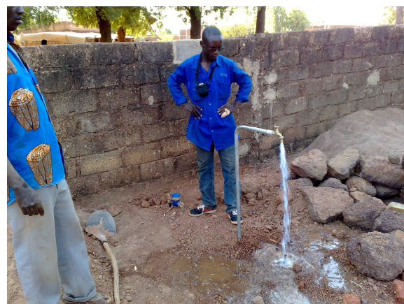
Zkouška individuální přípojky pitné vody, Toma
